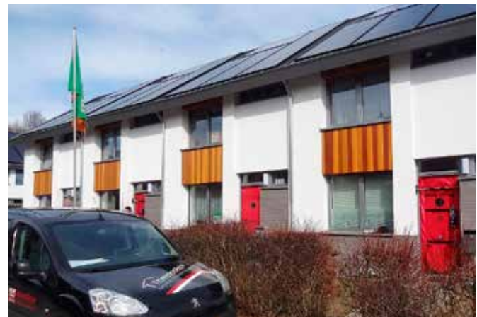
Opwaardering tot passiefhuis met behulp van blowerdoortest.
